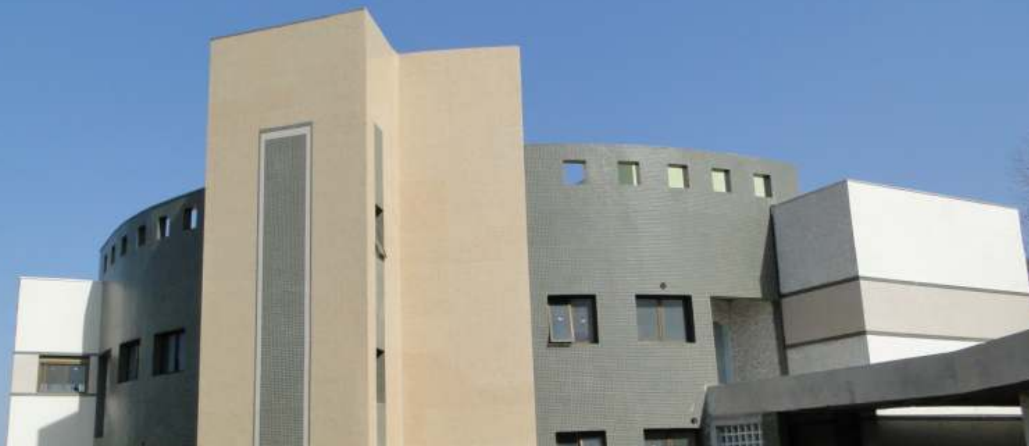
Lar Santa Rita de Cássia: obras em fase de conclusão
